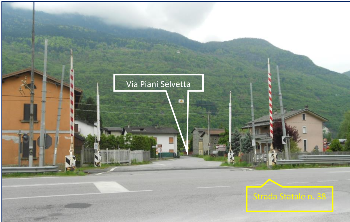
Passaggio a livello al km 26+055 da sopprimere
